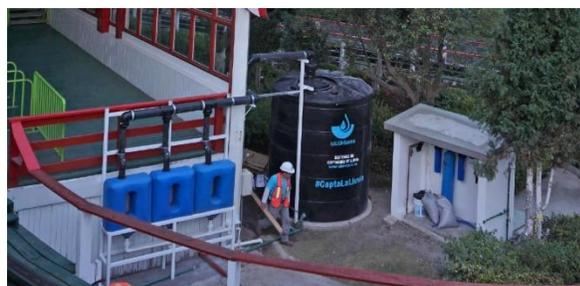
Figura 6. Sistema de captación de agua de lluvia para uso industrial (tomado de Isla Urbana, 2018).
