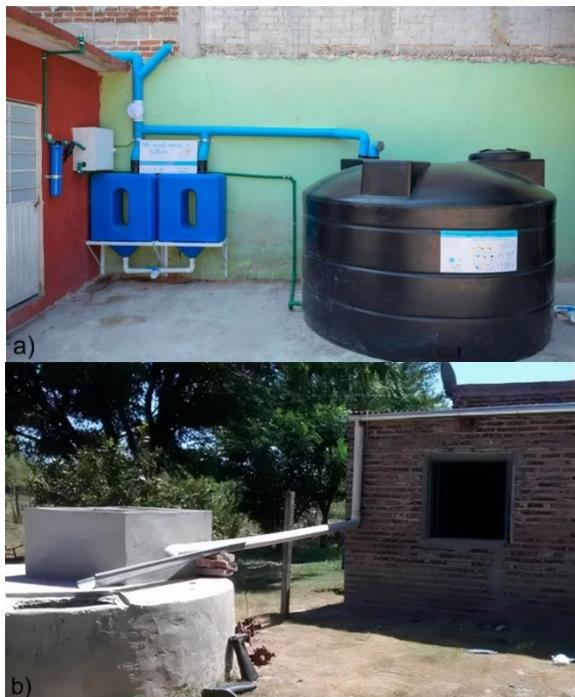
Figura 5. a) SCALL con almacenamiento en tanques; b) SCALL con almacenamiento en depósitos o albijes (tomado de Isla Urbana, 2019; INTA, 2013).
